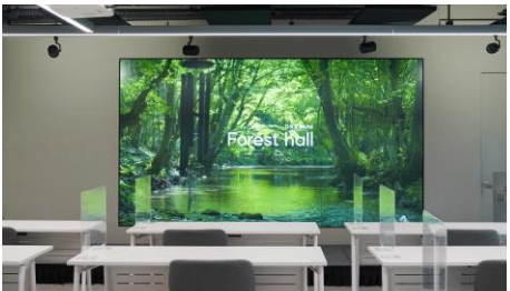
멀티비전 세미나실 내 설치
